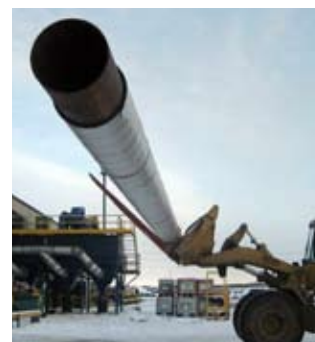
Tubo Pré-Isolado: O Pyrogel permite o pré-isolamento e o transporte subsequente do tubo.
